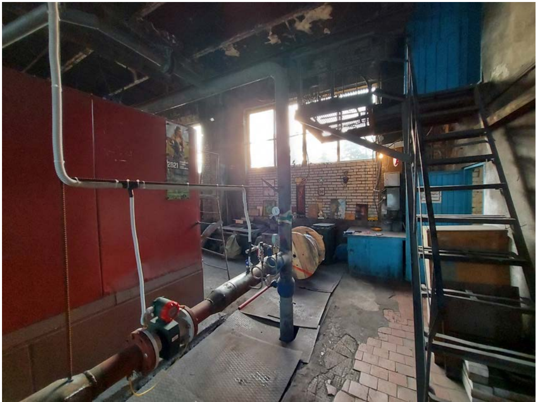
Рисунок 12 Внешний вид узла учета подающего трубопровода отопления на котельной п.ст. Громово
