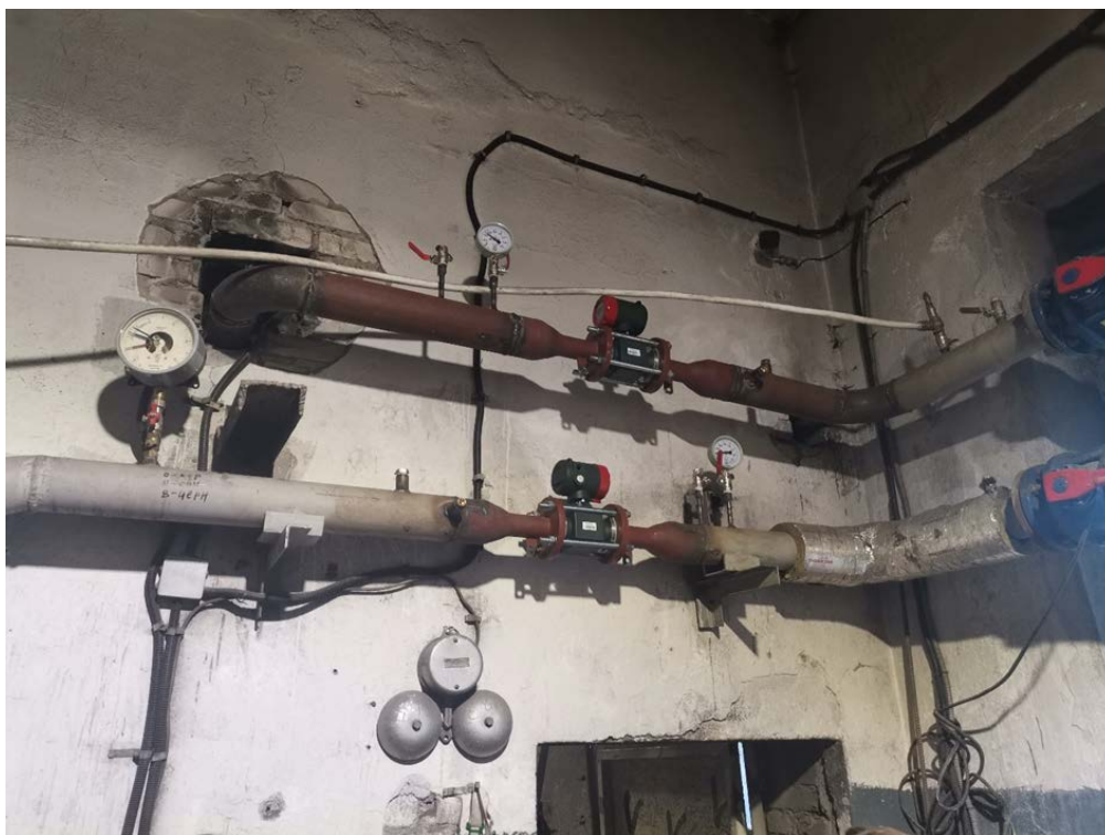
Рисунок 13 Внешний вид узлов учета трубопровода отопления на котельной п. Владимировка
