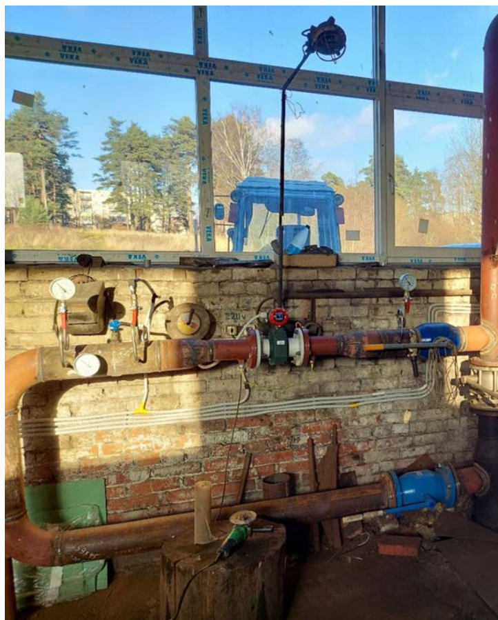
Рисунок 8 Внешний вид узла учета подающего трубопровода отопления на котельной п. Громово
